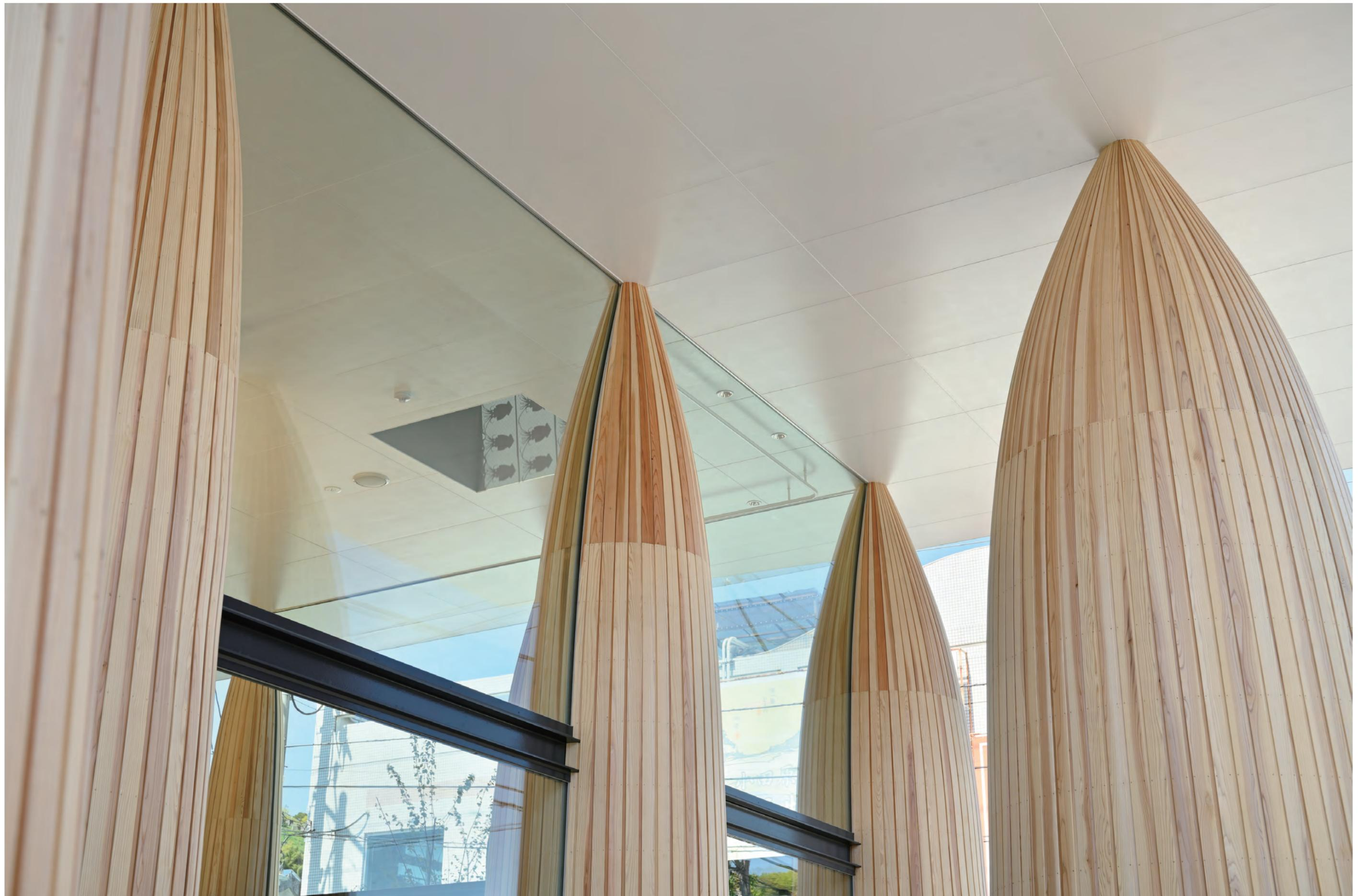
柱の仕上げの杉板張りは目地幅の調整によって、曲面施工に対応している。また、広く取った目地によって凹凸をつくり、立体感を生み出している。
