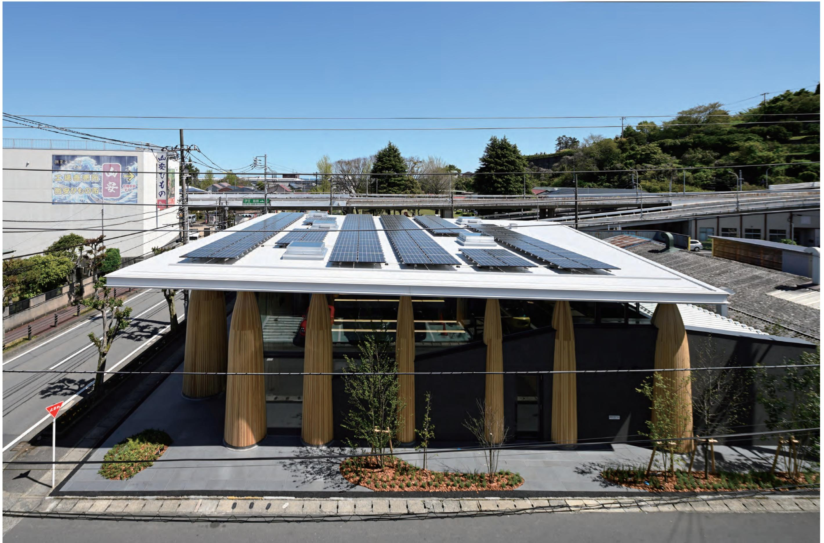
西側から俯瞰する。屋根は、北側に向けて勾配をとっている。換気と排煙のために開閉式のトップライトを設けており熱線反射ガラスを用いることで熱負荷を抑えながら、大屋根の圧迫感を軽減させている。
