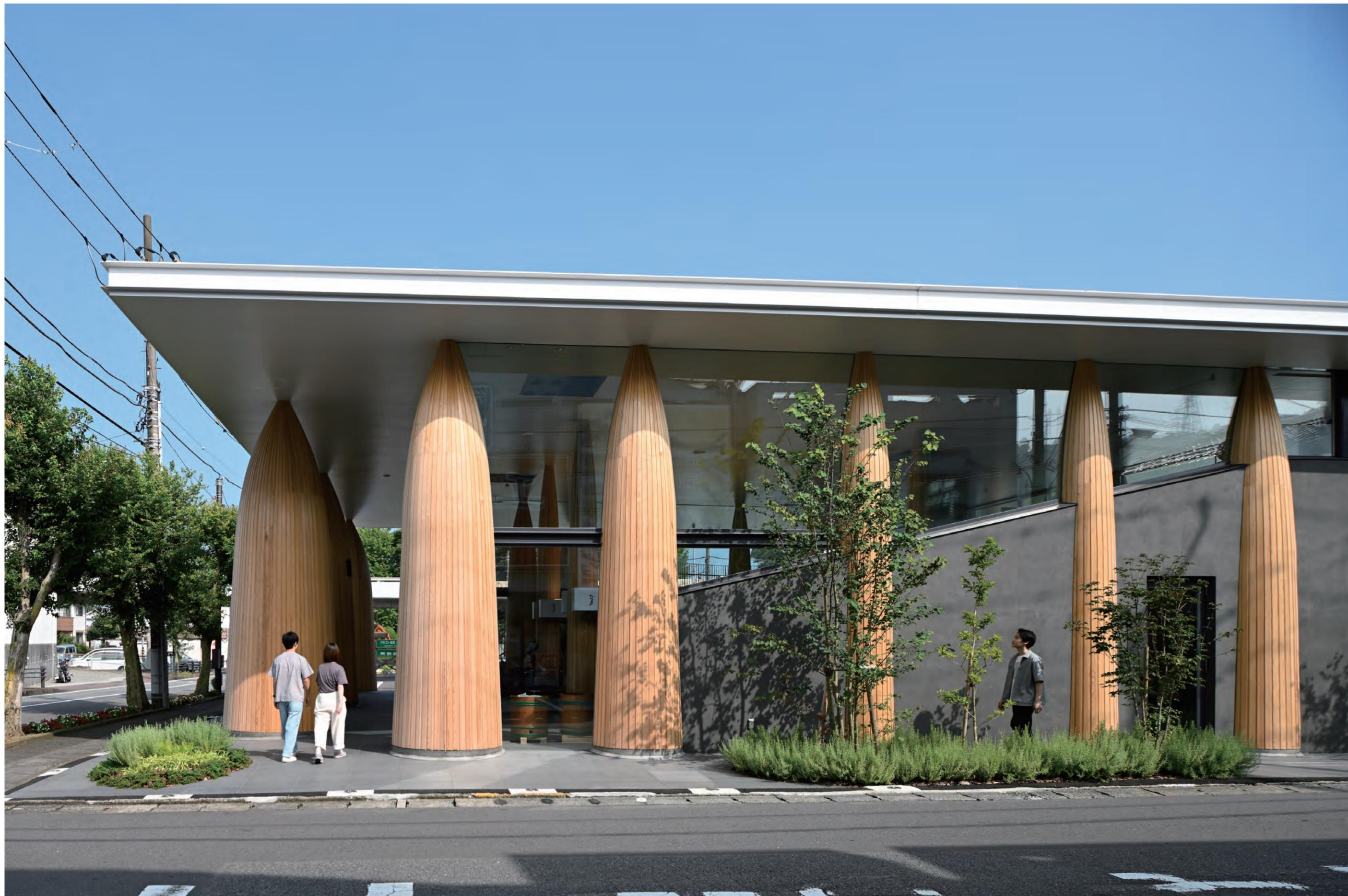
西側からみる外観。西面の複層ガラスには Low-E ガラスを使用し、植栽帯を設ける西日対策を行っている。
